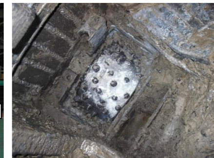
写真-7 ①箇所ビット確認(交換前)
