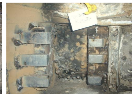
写真-8 ①箇所ビット交換後
