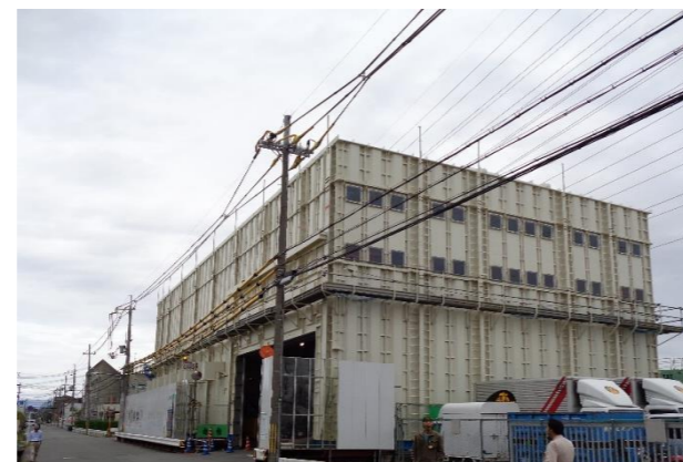
写真-2 作業ヤード状況
