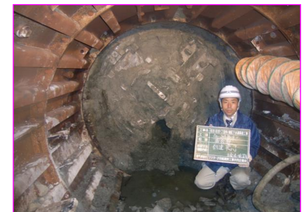
写真-2 シールド機地中接合
