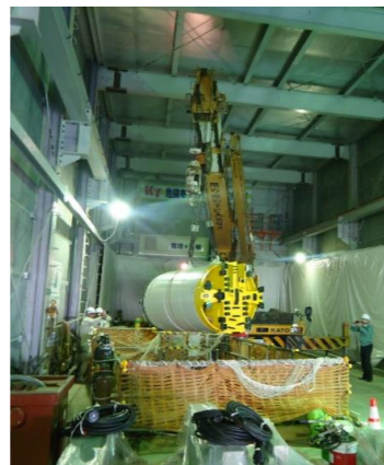
写真-2 掘進機投入状況
