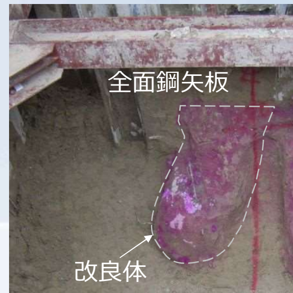
写真-2 背面改良状況
