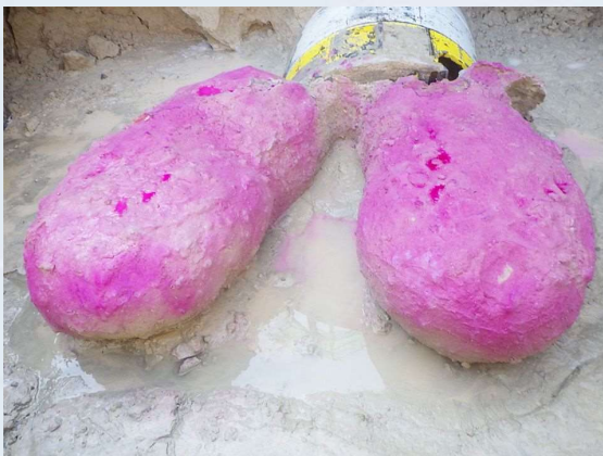
写真-1 セメント系地盤改良
