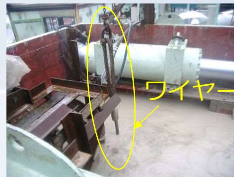
写真-2 切断噴射状況
