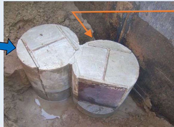
PIP杭切断面
