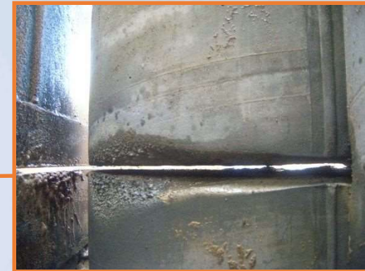
PIP杭切断線
