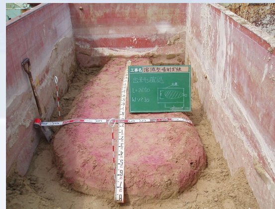
写真-2 溶液型地盤改良
