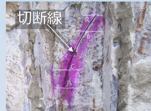
写真-1 切断線状況
