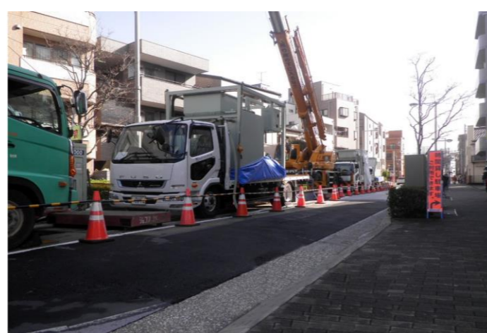
写真-2 作業ヤード状況
