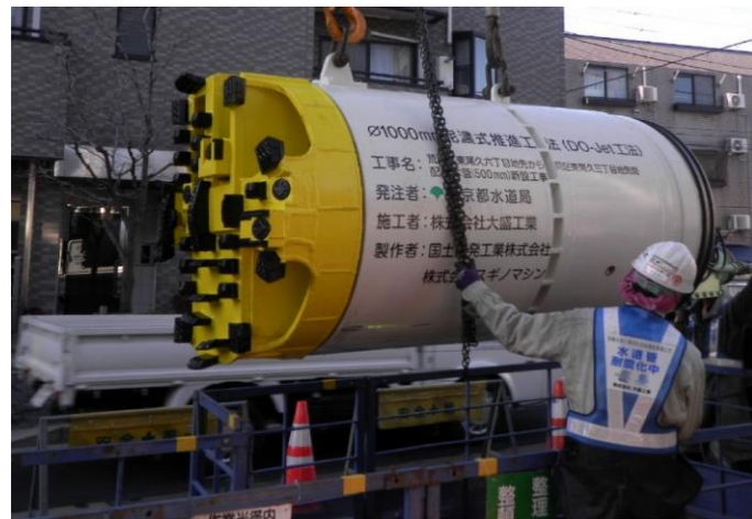
写真-1 本工事で使用したDO-Jet掘進機
