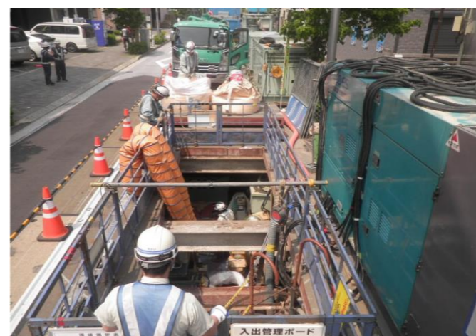
写真-3 発進立坑作業風景
