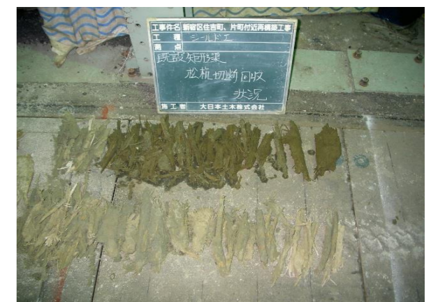
写真-1 松杭回収状況
