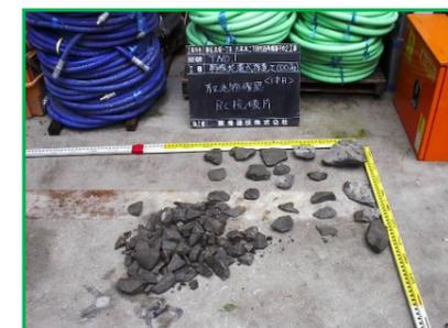
写真-1 RC杭破片回収状況
