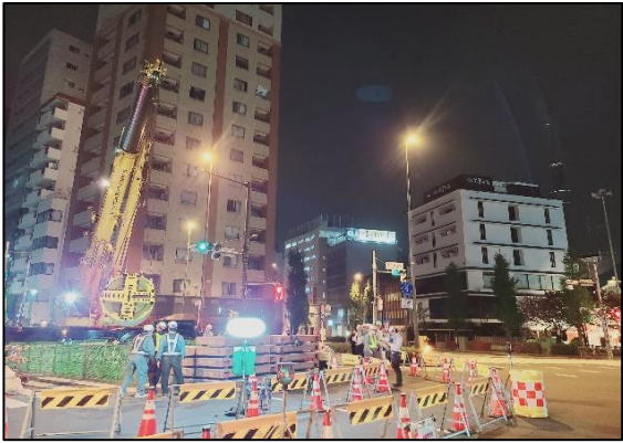
写真－2 掘進機投入状況
