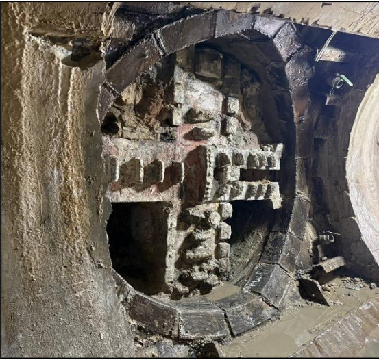
写真－4 地中接合(完全接合)完了
