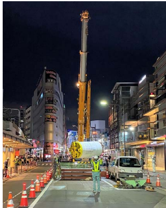
写真-1 φ1,350mm掘進機投入状況
