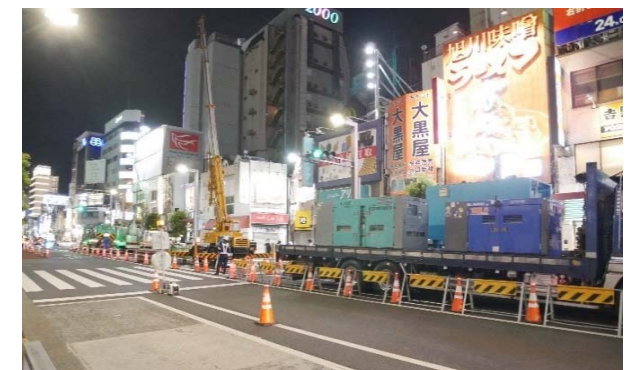
写真-3 車上プラント状況②
