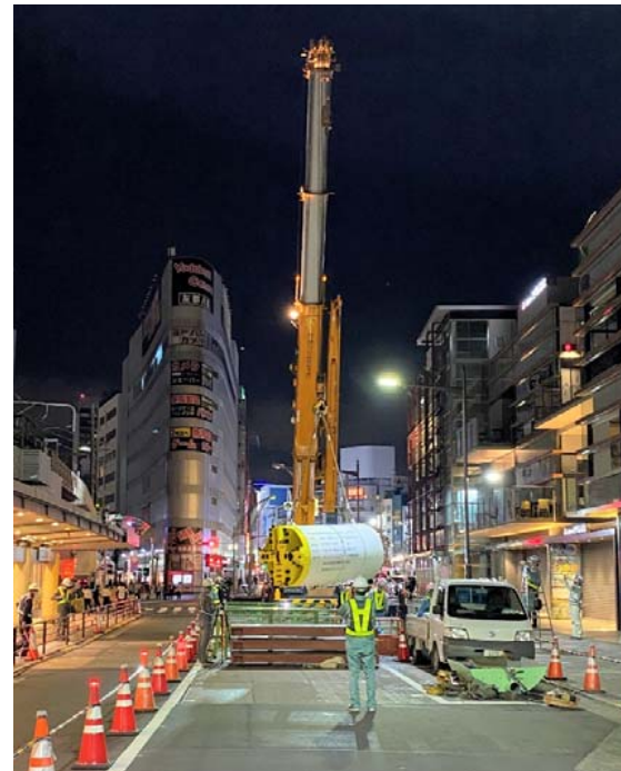
写真-1 φ1,350mm掘進機投入状況
