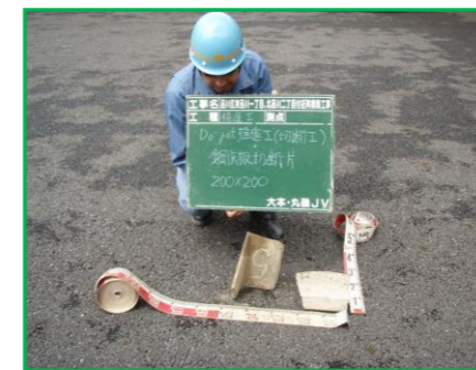
写真-2 鋼矢板Ⅲ型回収状況Ⅱ
