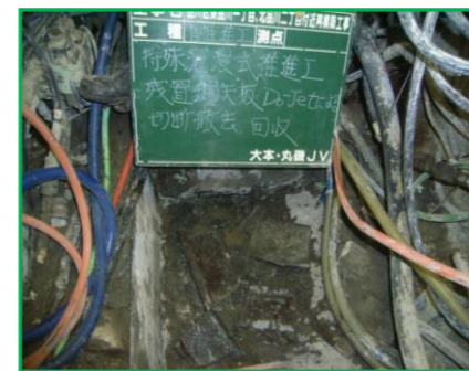
写真-1 鋼矢板Ⅲ型回収状況
