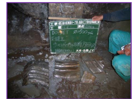
写真-3 H形鋼-300回収状況
