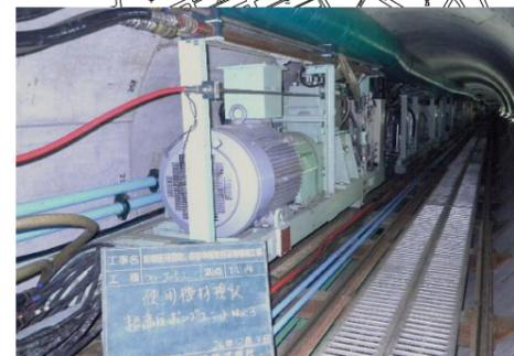
写真-3 坑内用超高圧発生装置
