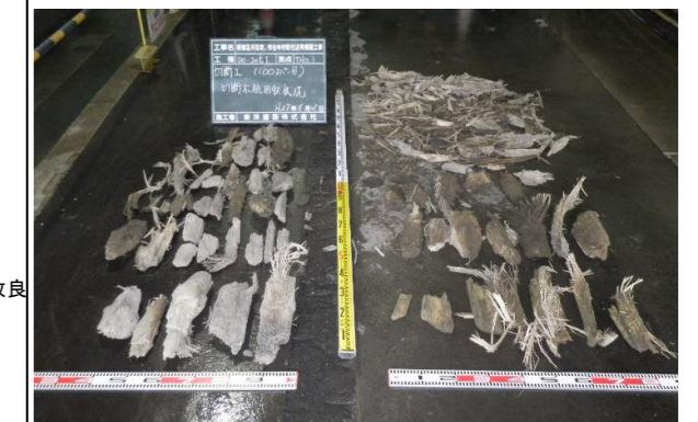
写真-1 木杭回収状況
