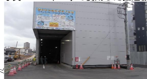
写真-2 防音建屋
