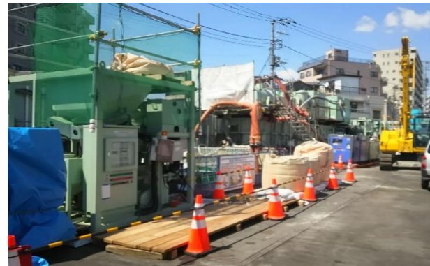
写真-2 作業ヤード状況
