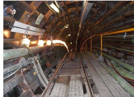
写真-1 24%下り勾配手前
