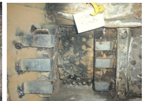
写真-8 ①箇所ビット交換後
