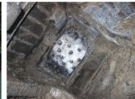
写真-7 ①箇所ビット確認(交換前)
