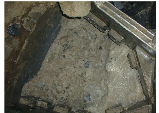
写真-5 地盤改良効果確認(開口部)
