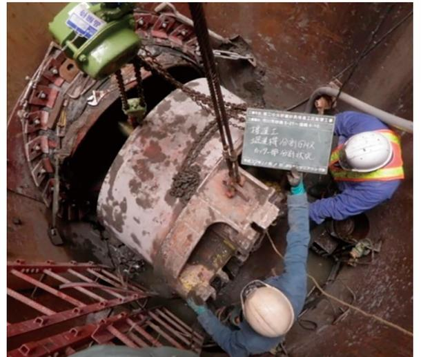
$\phi 1,200\text{mm}$ 掘進機分割回収状況（到達）
