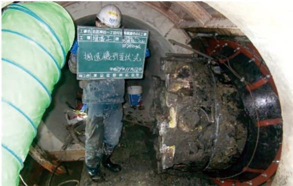
$\phi 900\text{mm}$  掘進機地中接合状況
