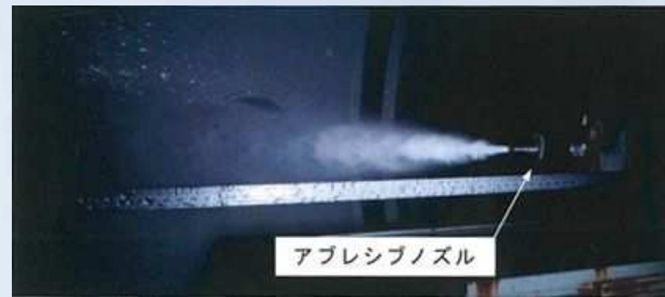
写真3 噴射状況（2液混合）
