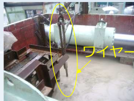
写真-2 切断噴射状況
