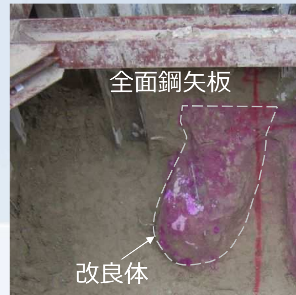
写真-2 背面改良状況
