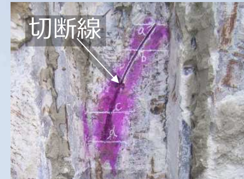
写真-1 切断線状況
