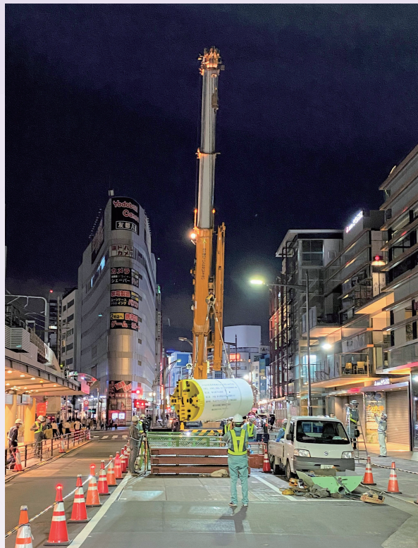
JR上野駅前φ1,350mm掘進機投入状況
