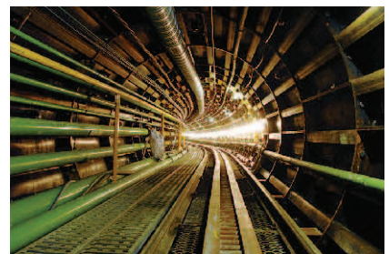
既設水路の真下へ通す急カーブ
