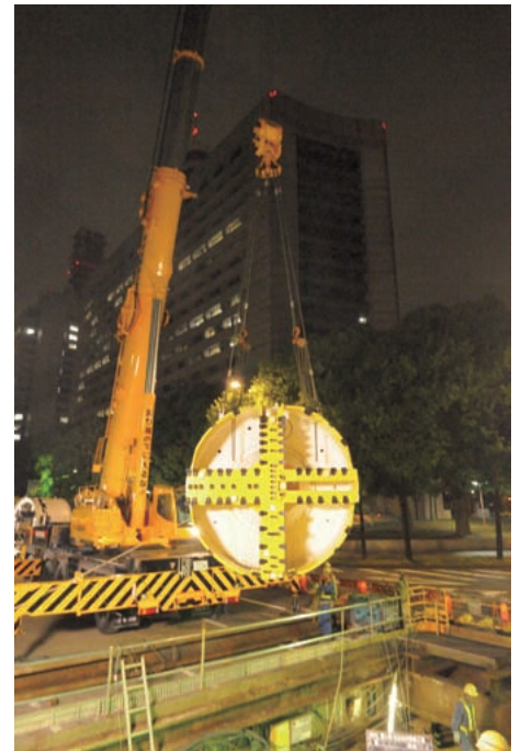
掘進機投入のまよう (平成 22 年 5 月 11 日未明) ▶ (背後のビルは警視庁庁舎)
