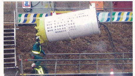
遠山ルート配水管布設工事 マシン投入風景
