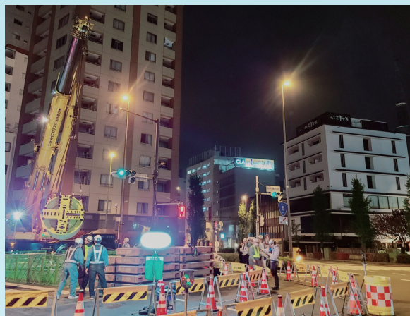
φ1,500mm 掘進機投入状況
