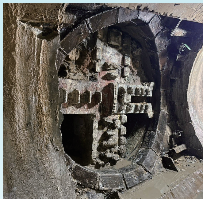
地中接合完了状況
