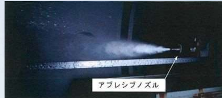
写真3 噴射状況（2液混合）
