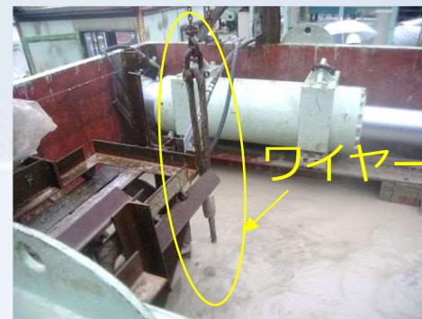
写真-2 切断噴射状況
