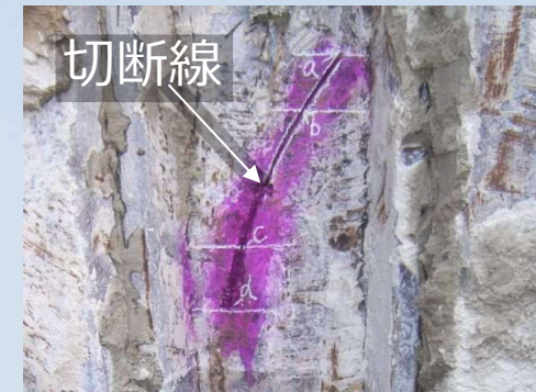
写真-1 切断線状況
