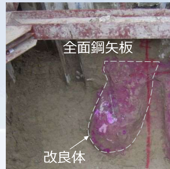
写真-2 背面改良状況
