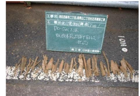
写真-1 松杭切断回収
